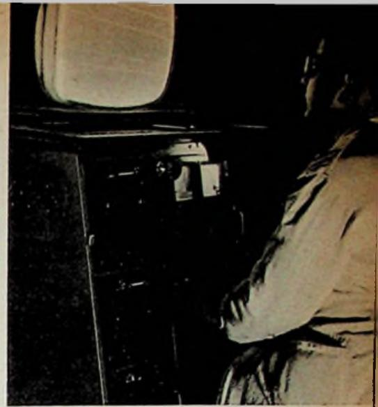
Bild 4. Die elektrischen und optischen Prüfungen erfolgen in dem neuen Bildröhrenwerk von Telefunken in Ulm in Spezialmeßständen. Die Meßgeräte zeigen die Strom- und Spannungswerte, das Katodenbild, Schirmhelligkeit, Strahlschärfe und Ausblendung an
